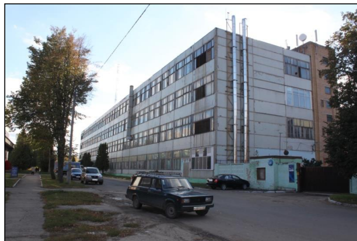
Вид на современное здание ООО "Зарайск-обувь" со стороны ул. Мерецкова
