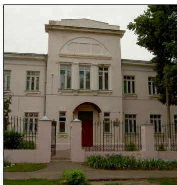
(ул. Гуляева, 16, здание бывшего приюта)
